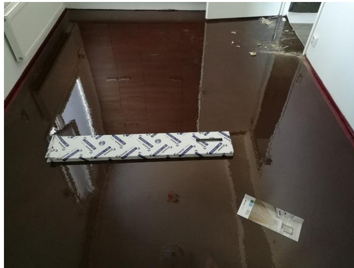
kapselointiepoksi asennettu
