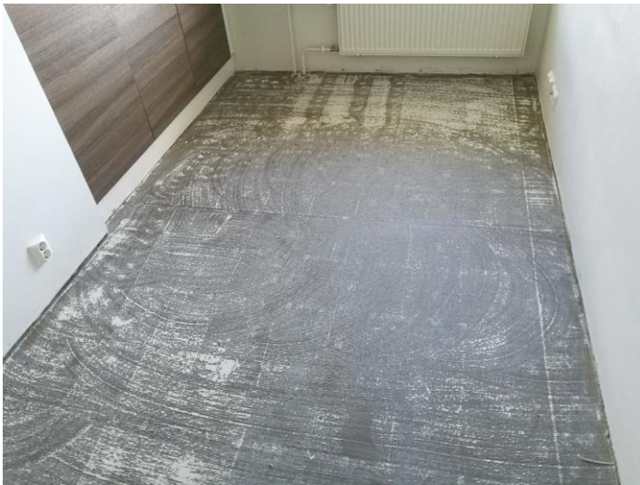
Matto poistettu, liiman & tasoitteen hionta kesken
